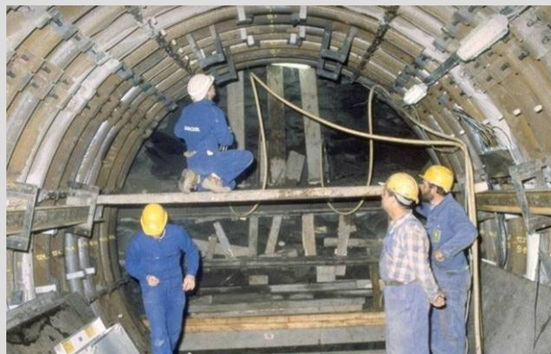
Figuur 3.27 De drie bekledingstypes die tot nog toe werden gebruikt in de ondergrondse galerijen: bovenaan, de bekledingssegmenten in nodulair gietijzer (experimentele galerij HADES); in het midden, de betonnen gewelfstenen (kleine galerij en Test Drift); onderaan, de metalen glijprofielen (Test Drift, deel ANDRA).
