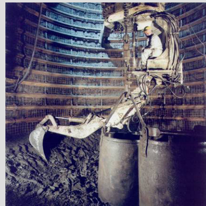
Figuur 3.28 Graven van de tweede schacht: bovenaan, het graven van de aanzet van de verbindingsgalerij; onderaan, de hydraulische arm en de metalen glijprofielen.
